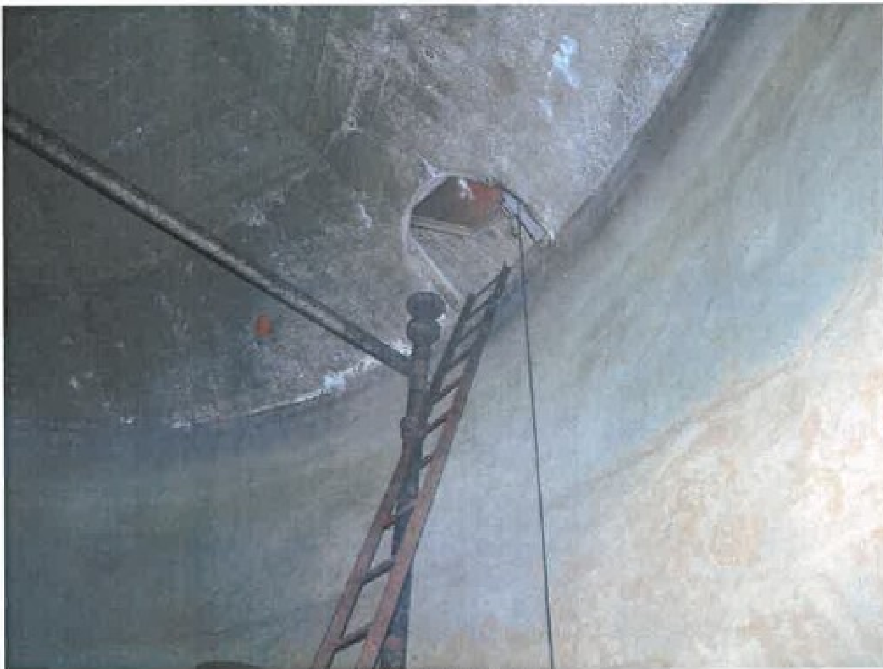
Accès à la cuve
