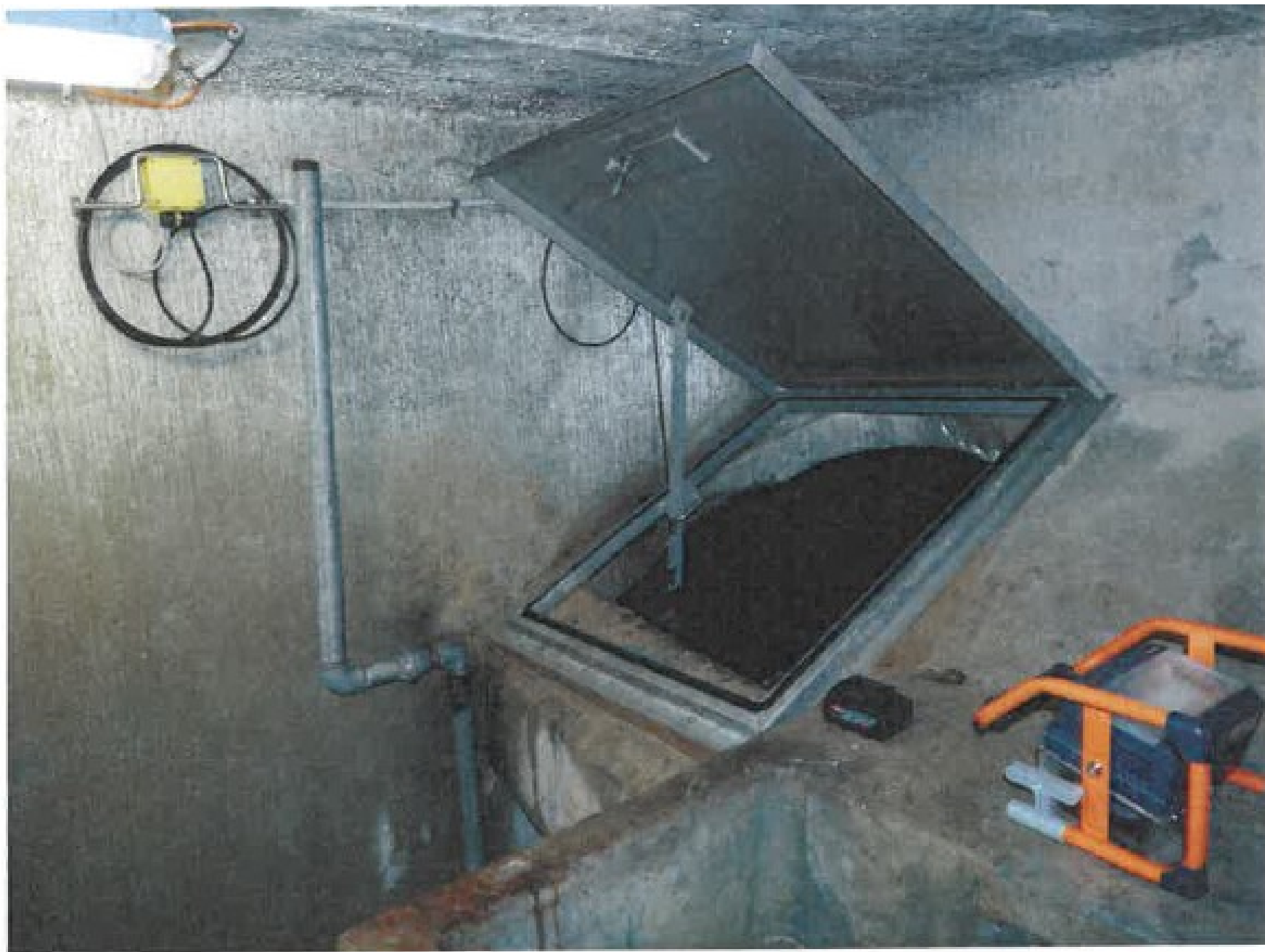
Accès à la cuve
