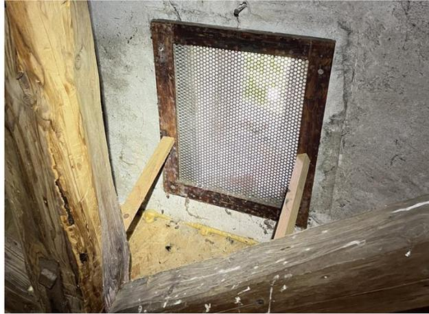
**Figure 14**, ID 4, Grille installée devant la fenêtre des combles de l'église, une simple ouverture de 7 cm de large sur 20cm de long suffirait pour recouvrir un gîte attractant aux chauves-souris.
